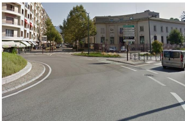
Giratoire de la Banque de France (Annecy) – Remplacement de la bande cyclable par un marquage en milieu d'anneau
