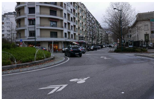
Giratoire de la Banque de France (Annecy) – Remplacement de la bande cyclable par un marquage en milieu d'anneau
